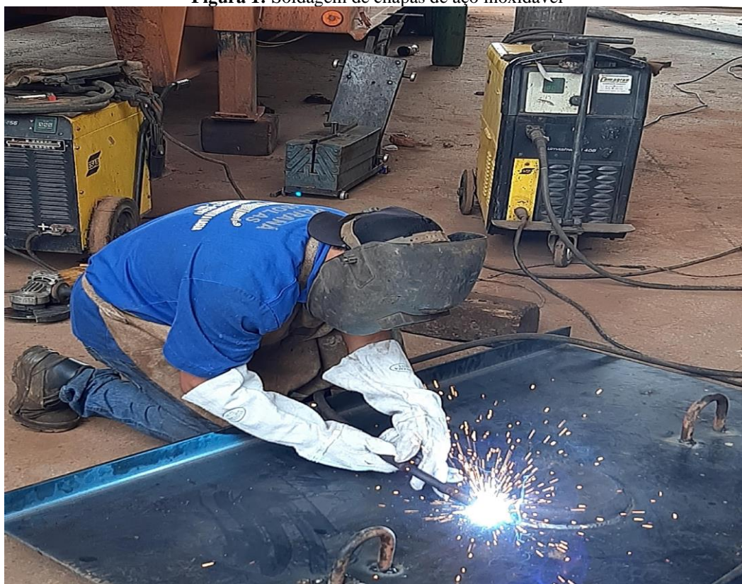
Figura 1: Soldagem de chapas de aço inoxidável
