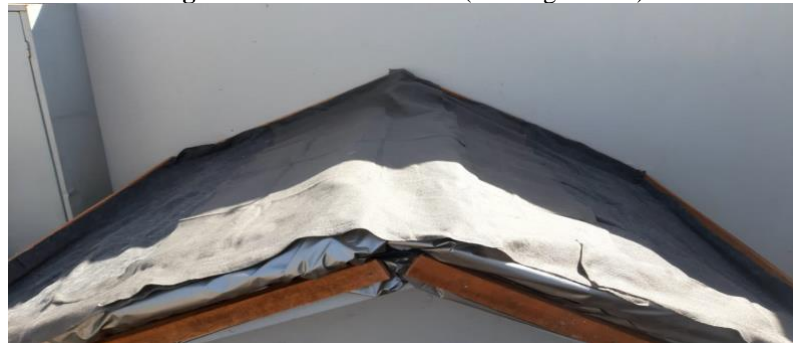
Figura 4: Camada Filtrante (mante geotêxtil).
