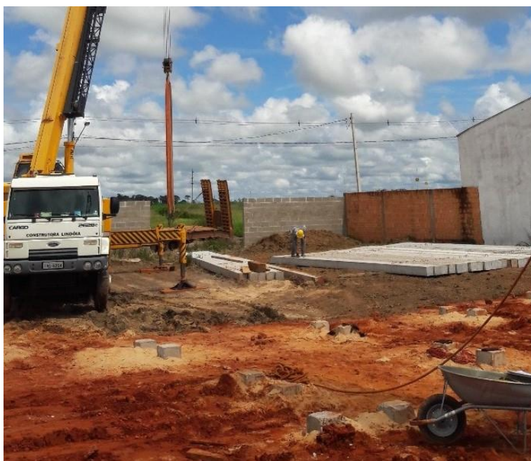
Figura 7: Estacas protendidas sendo distribuidas no canteiro de obras – Sinop MT
