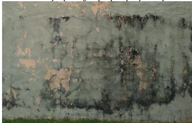
Figura 4: Manifestação patológica por precipitação em parede externa
