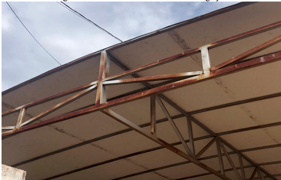
Figura 7: Falha de concordância nas ligações
