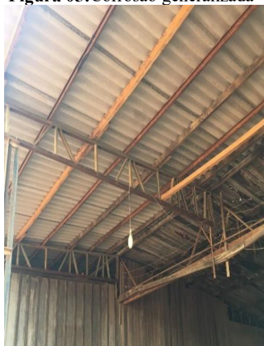
Figura 05: Corrosão generalizada
