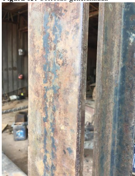
Figura 03: Corrosão generalizada
