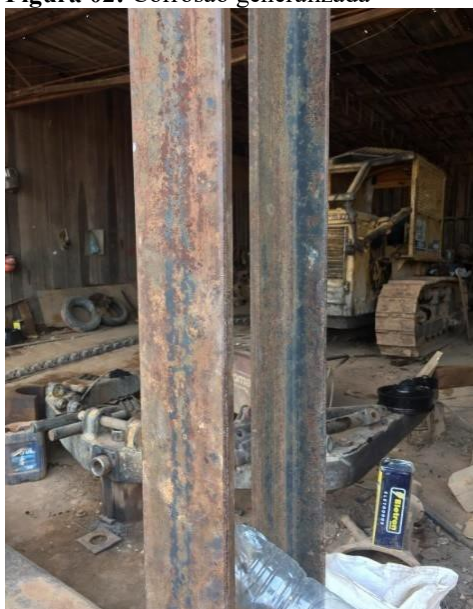
Figura 02: Corrosão generalizada
