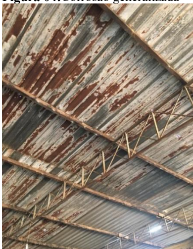
Figura 04: Corrosão generalizada
