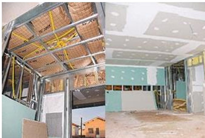
Figura 24: Construção da parte interna de uma das casas da Vila Dignidade.
