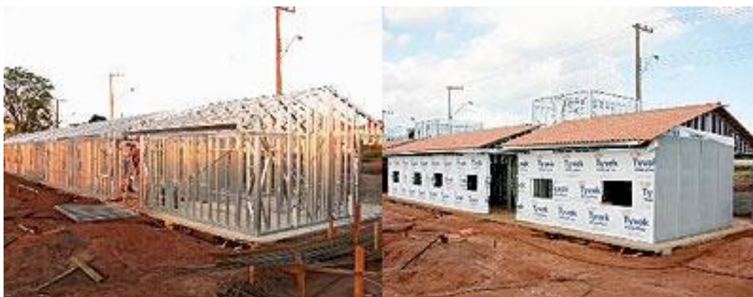
Figura 23: Construção das casas do conjunto habitacional Vila Dignidade utilizando o sistema LSF.
