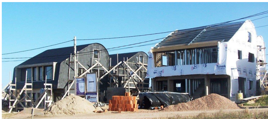
Figura 17: As 4 unidades em processo de construção com sistemas construtivos distintos.
