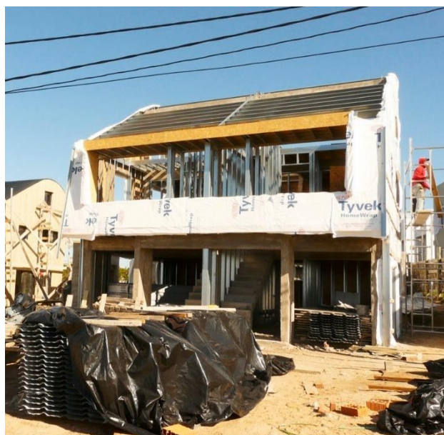
Figura 18: Unidade em construção que utiliza o sistema LSF.
