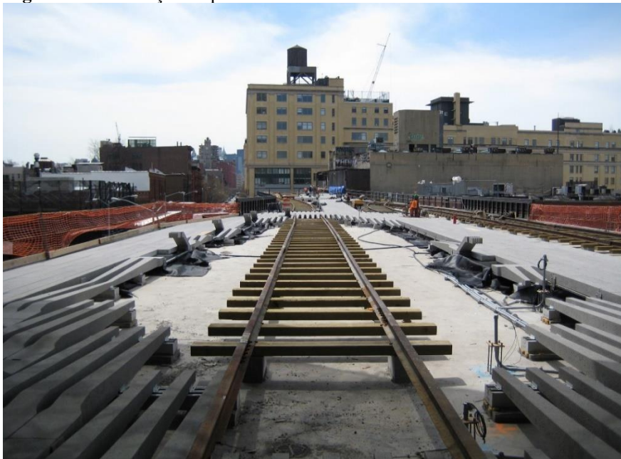
Figura 03: Construção do primeiro trecho
