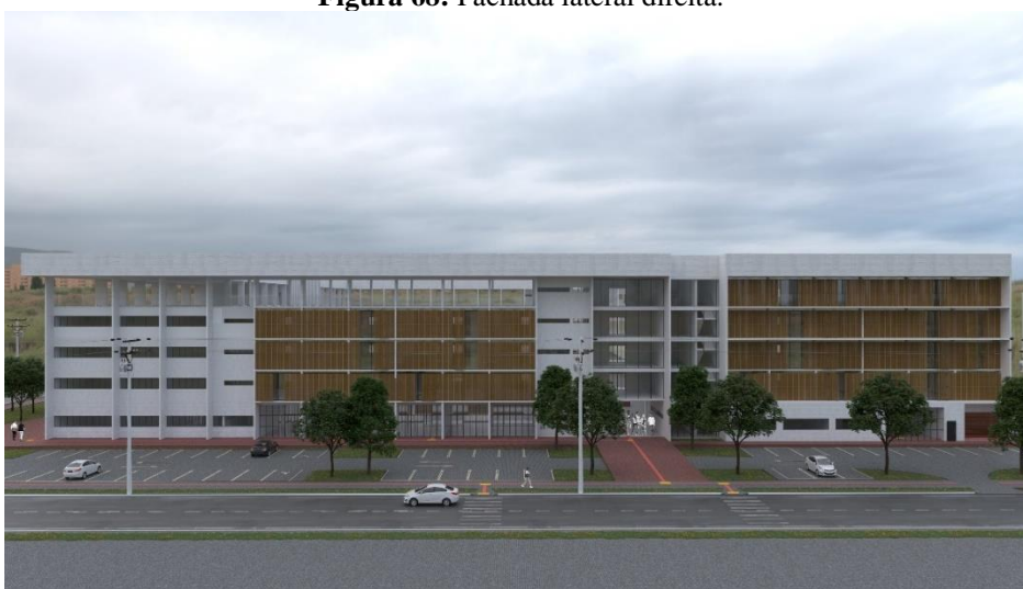
Figura 68: Fachada lateral direita.
