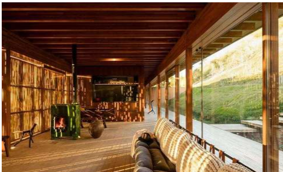
Figura 6 – Estrutura em MLC
