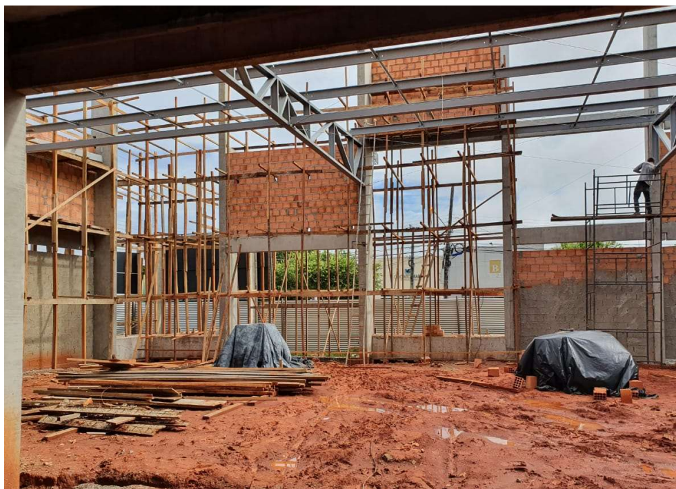
Figura 5: Organização do canteiro de obras.
