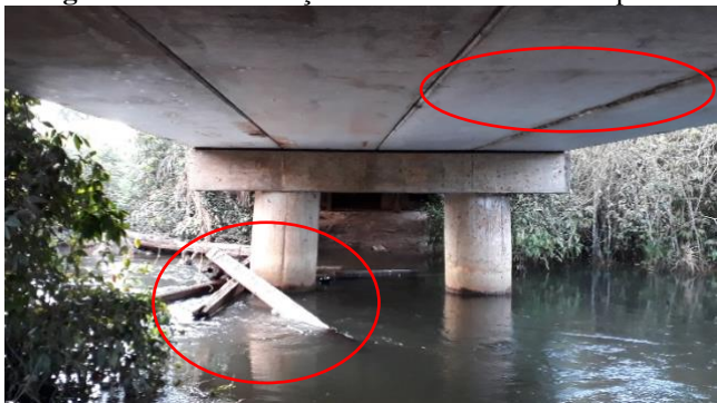
Imagem 23: Vista da seção transversal inferior da ponte.
