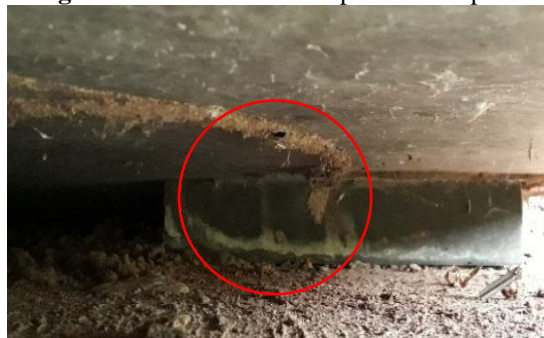
Imagem 10: Vista frontal do aparelho de apoio.
