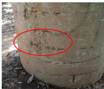
Imagem 48: Armadura exposta.
