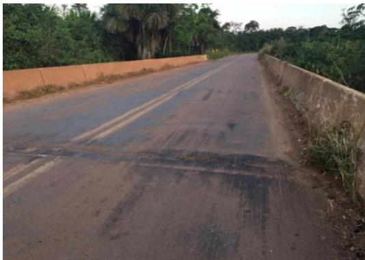
Imagem 5: Vista frontal superior do tabuleiro da ponte sobre o Rio Ribeirão Azul.
