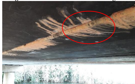
Imagem 32: Vista da face inferior das vigas.
