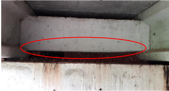
Imagem 27: Transversina de apoio.
