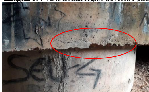
Imagem 39: Vista frontal região travessa e pilar.
