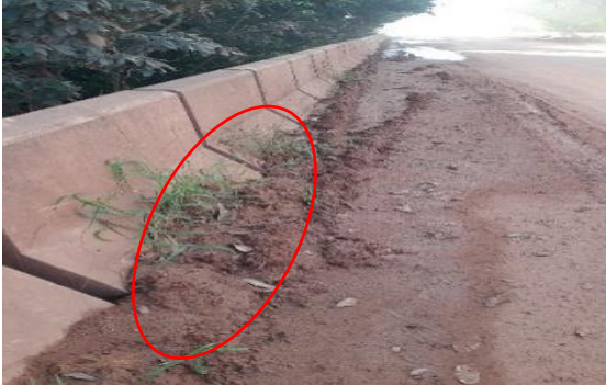
Imagem 19: Lateral da pista do tabuleiro.
