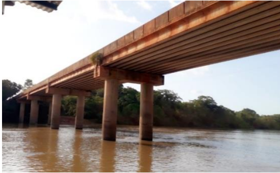
Imagem 3: Vista lateral da ponte sobre o Rio Teles Pires.
