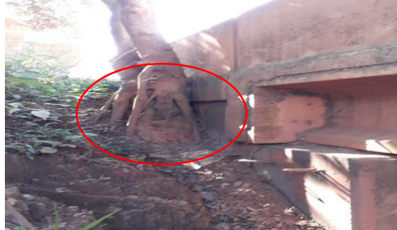
Imagem 30: Lateral da cabeceira da ponte.
