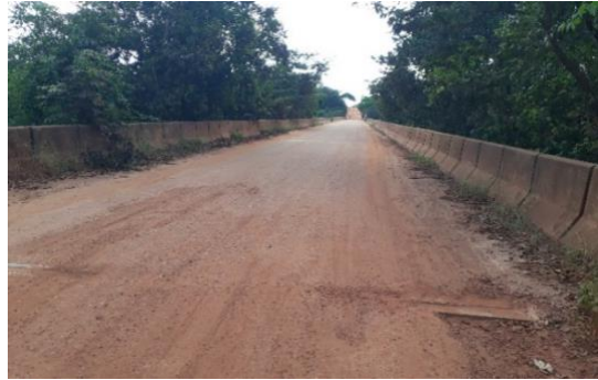
Imagem 4: Vista frontal do tabuleiro da ponte sobre o Rio Teles Pires.
