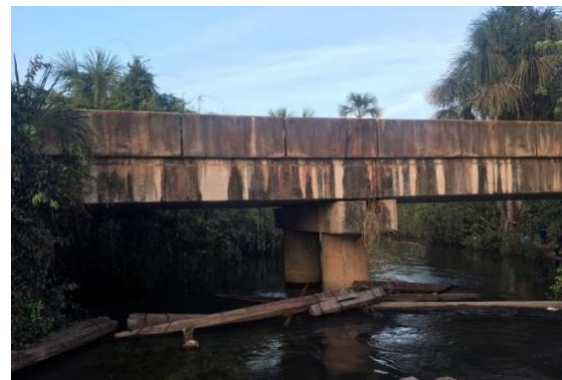
Imagem 6: Vista lateral da ponte da ponte sobre o Rio Ribeirão Azul.
