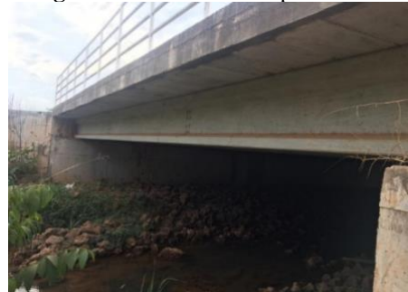
Imagem 2: Vista lateral da ponte urbana.
