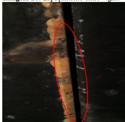
Imagem 26: Espaçamento entre vigas.
