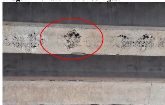
Imagem 41: Face inferior de vigas.
