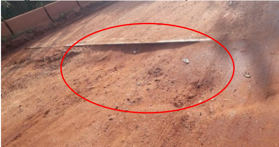
Imagem 21: Vista da cabeceira da ponte.
