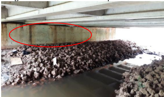
Imagem 31: Vista do encontro da ponte.
