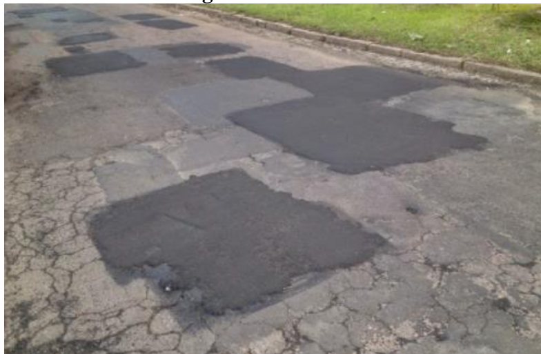
Figura 12: Remendo
