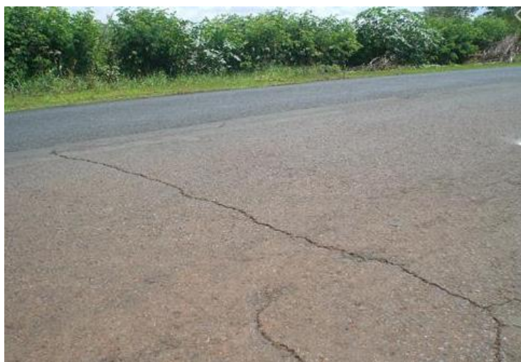
Figura 5: Trinca transversal
