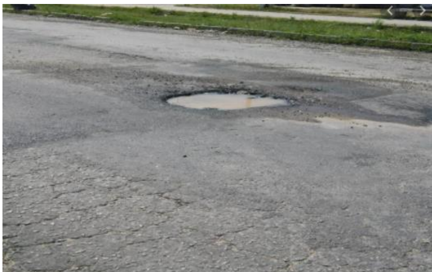
Figura 11: Panela ou buraco
