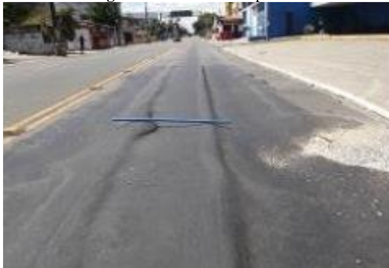
Figura 9: Afundamento plástico
