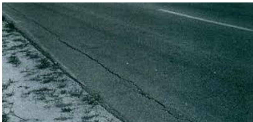
Figura 6: Trincas longitudinais
