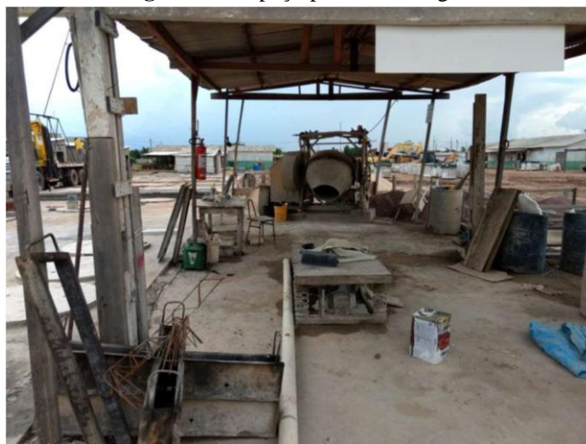
Figura 12: Espaço para concretagem
