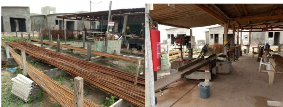
Figura 11: Armazenamento das ferragens e corte
