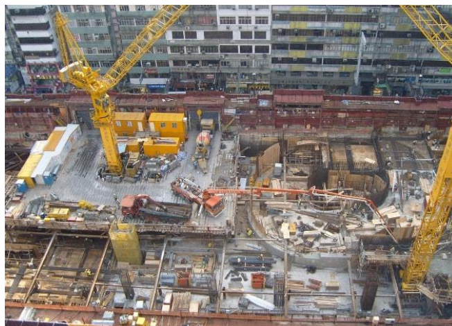
Figura 1: Canteiro de obras do tipo restrito
