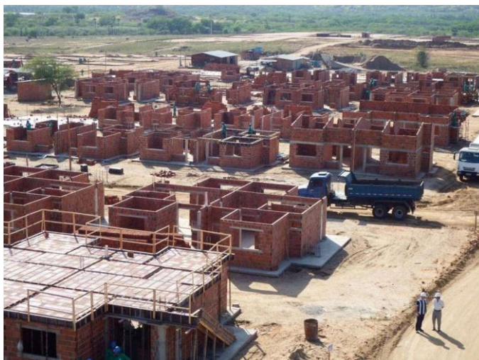
Figura 2: Canteiro de obras do tipo amplo
