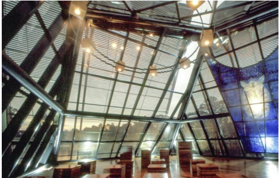
Figura 14: Estrutura de aço fechada de vidros do Templo da Paz Fonte: < http://www.mcacoelho.com.br 24 >
