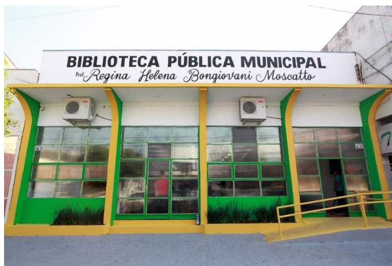
Figura 01: Imagem da Fachada da Biblioteca Pública de Sinop, 2017.
