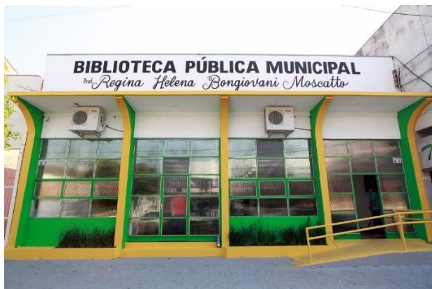
Figura 08: Imagem da Fachada da Biblioteca Pública de Sinop, 2017.
