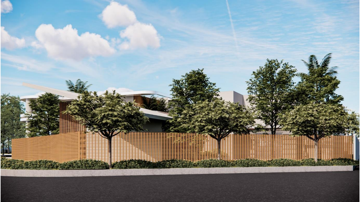
Figura 75 – Muro em cobogó.
