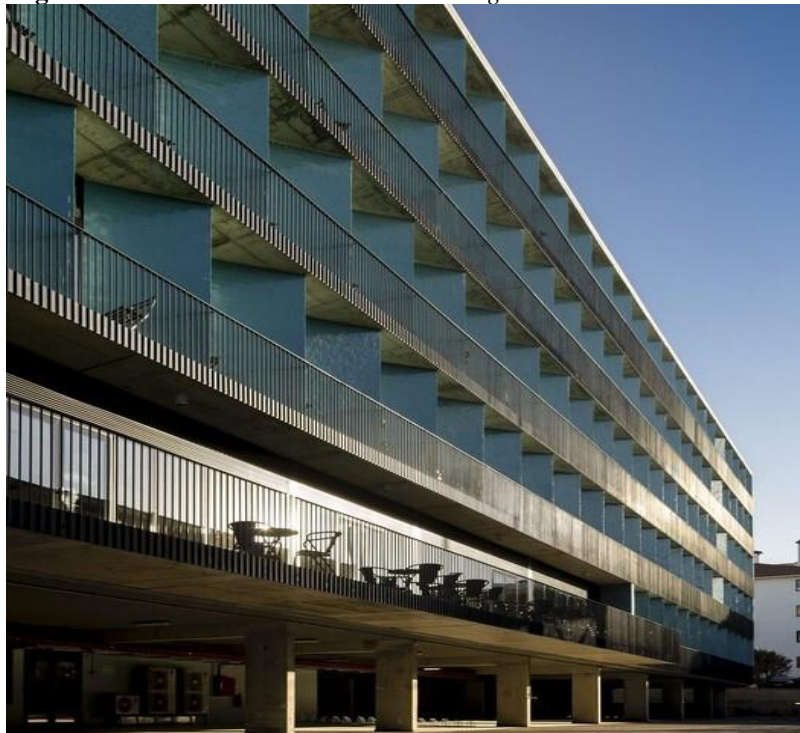
Figura 04 – Fachada dos fundos do Co-living Carcavelos.
