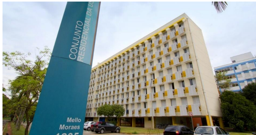
Figura 07 – Fachada principal do bloco do CRUSP.
