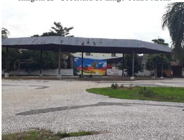
Imagem 23- Cobertura do antigo Teatro Arena
