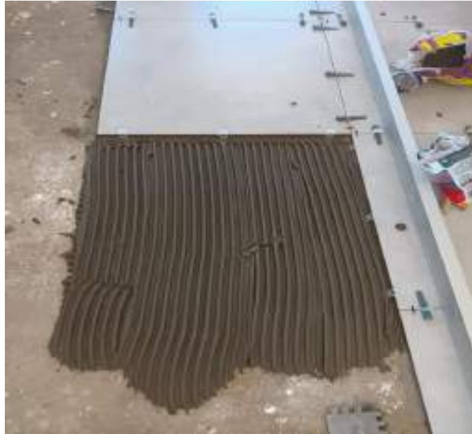
Figura 11: Empalhamento da argamassa
