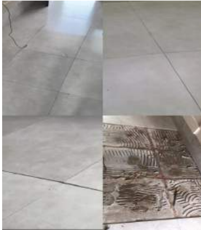
Figura 7: Peça iniciando o deslocamento
