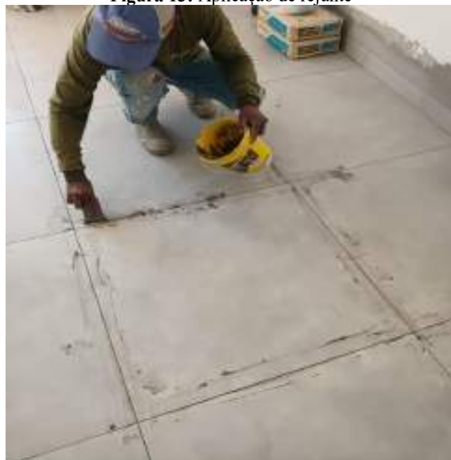
Figura 13: Aplicação de rejunte
