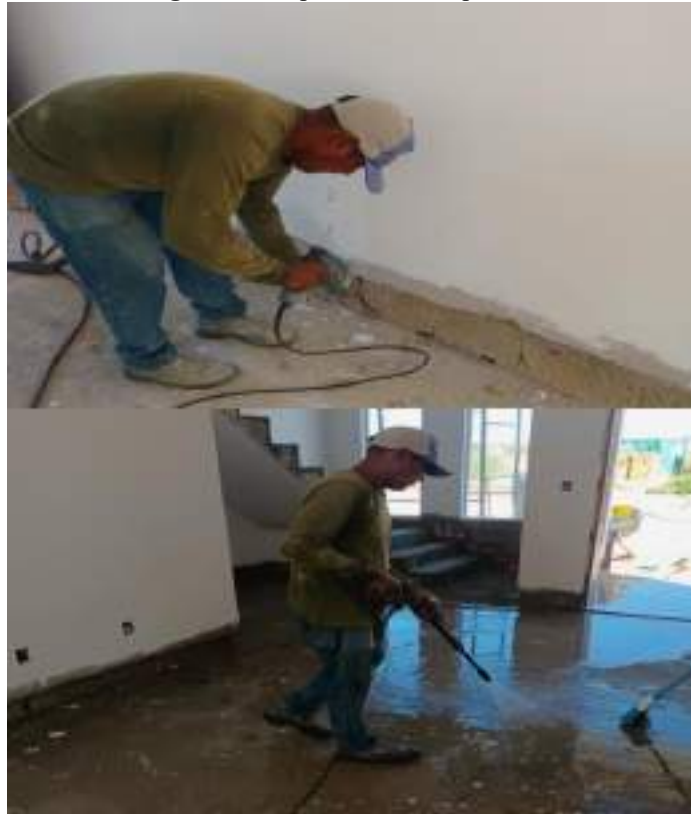
Figura 8: Limpeza do contra piso/base
