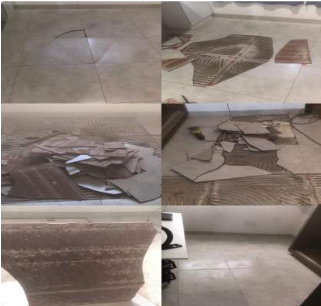
Figura 5: Cerâmica deslocadas
