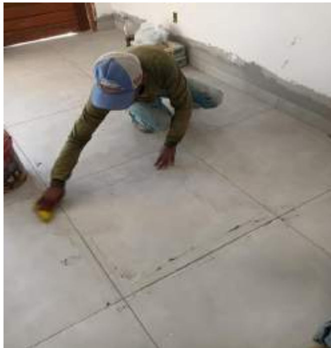
Figura 14: Limpeza do rejunte
